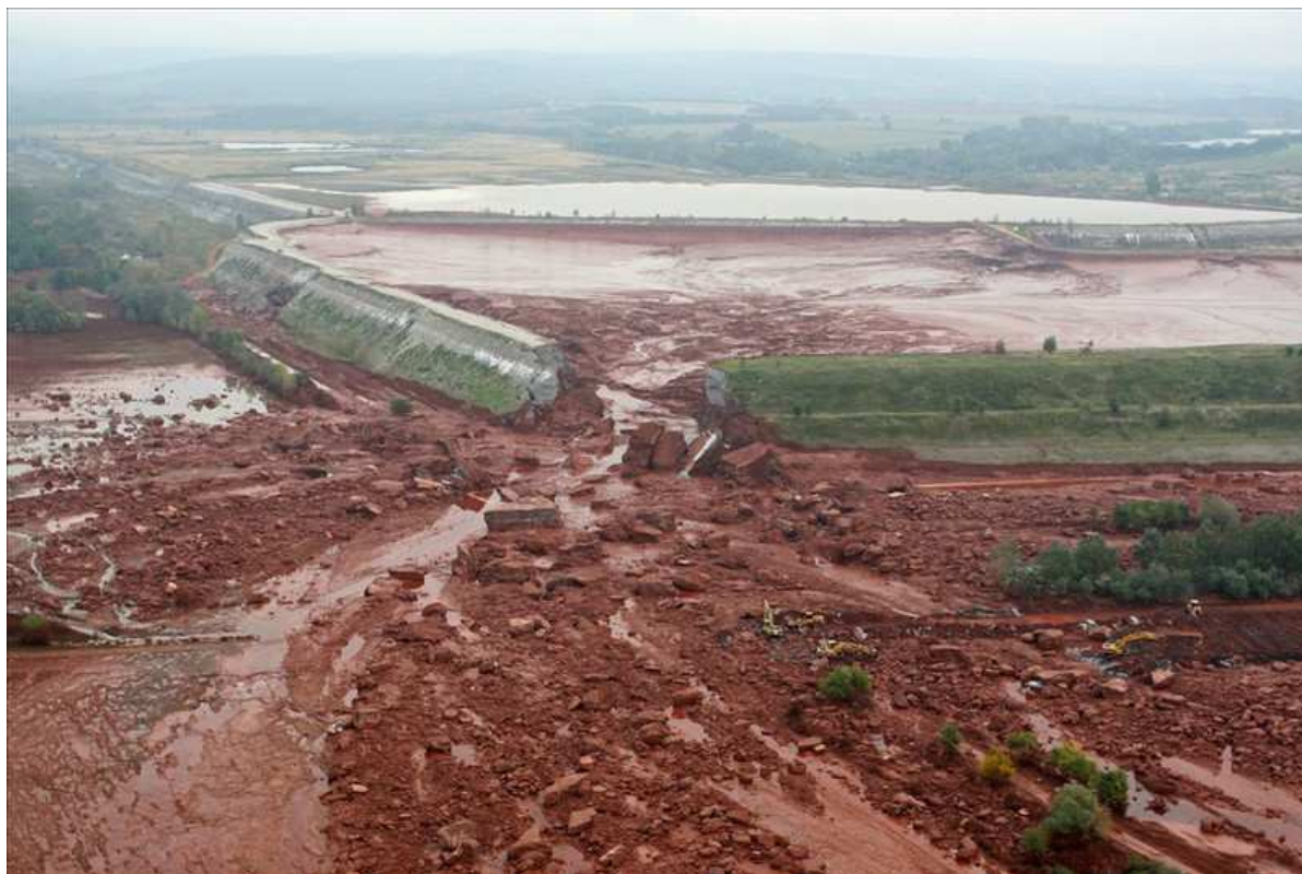
3. Enceinte après la rupture
