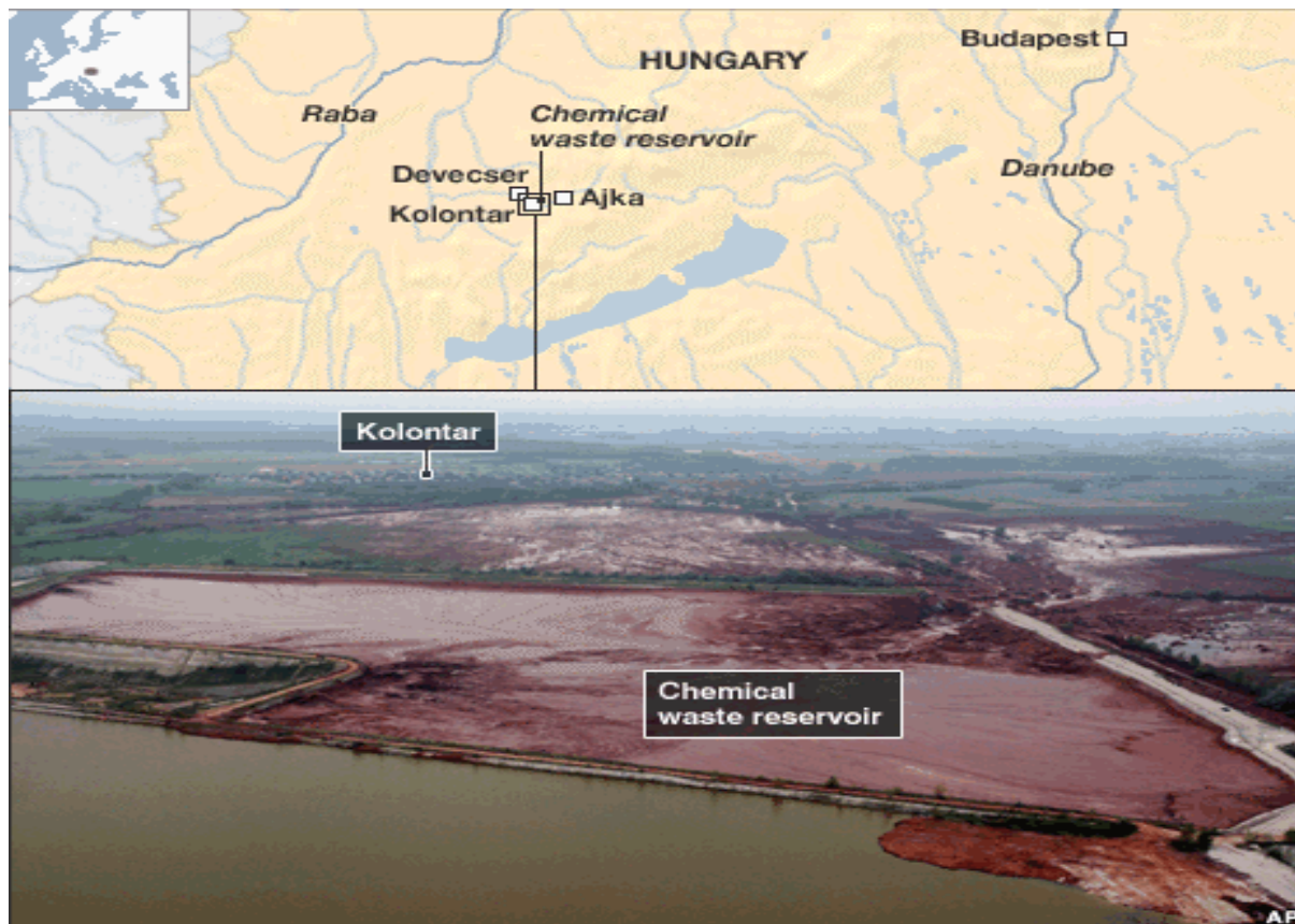
1. Emplacement du site
