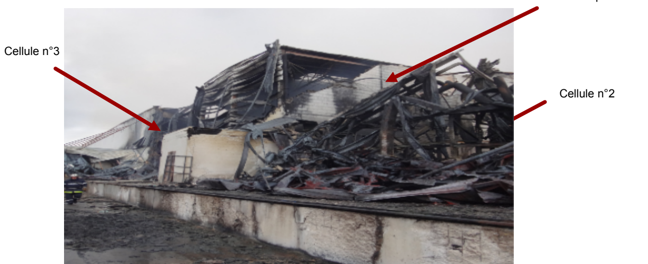
Vue de la façade Nord et du mur coupe feu entre les cellules 2 et 3 (source : DREAL Picardie)
