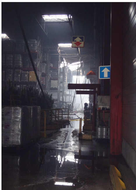
Vue de l'intérieur de la cellule 3 (source DREAL Picardie)
